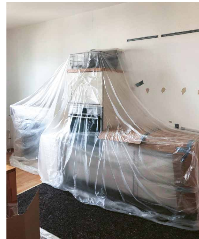
Damit nichts passiert: Küche wurde sicher verpackt
