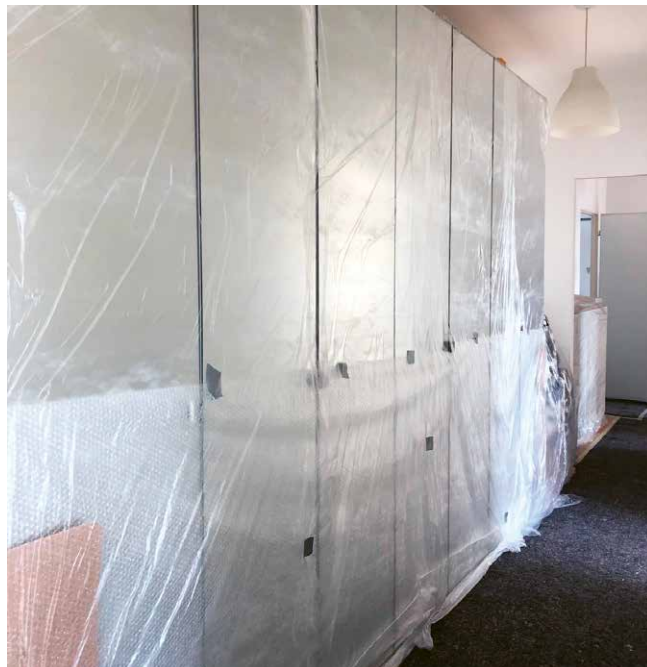
Alle Möbel wurden sorgfältig abgedeckt
