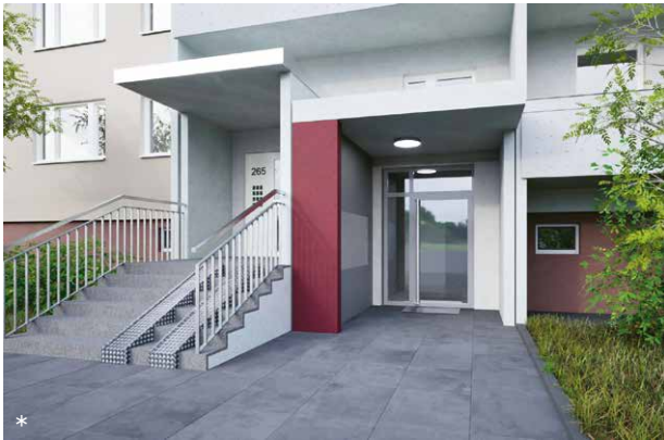
10 Bauprojekte 2025 Eines der Highlights in diesem Jahr: der Aufzugsanbau und die Neugestaltung der Eingangsbereiche in der Landsberger Allee 265 und der Altenhofer Str. 23
